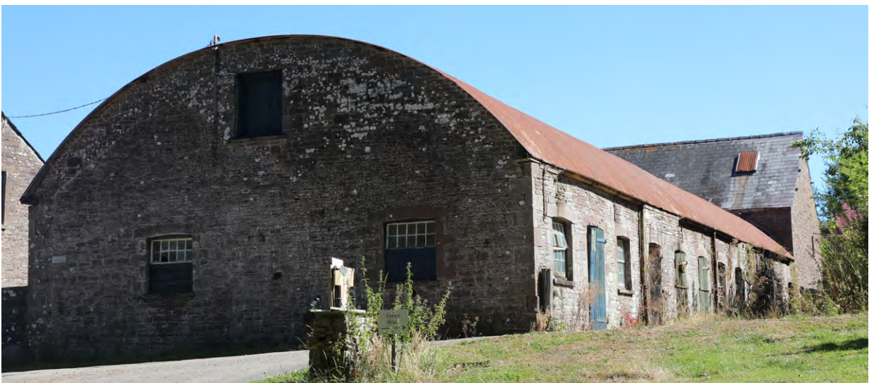
Y beudy/llaethdy yn y fferm fodol, Buckland Hall, a adeiladwyd gyda llwybr bwydo canolog. Ymddengys yn wreiddiol fod ganddo do polyn dwbl o wahanol uchder a gafodd ei ddisodli yn ddiweddarach gan do bwa un rhychwant o haearn rhychiog, y waliau pen wedi'u codi a llofft wedi'i gosod yn ei lle. Roedd y llofft yn storio ac yn trosglwyddo bwyd anifeiliaid o'r felin gyfagos. Llun © Sam Hale
