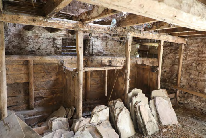
Tu mewn gyda chysylltiadau buchod siamffrog a llwybr porthiant, Llanigon. Lluniau © Sam Hale Clymau buwch sengl syml mewn ysgubor gyfunol, Dyffryn Crawnon – sylwch ar y llofft uchod gyda pholion cyll wedi eu bwndelu. Llun © Sam Hale
