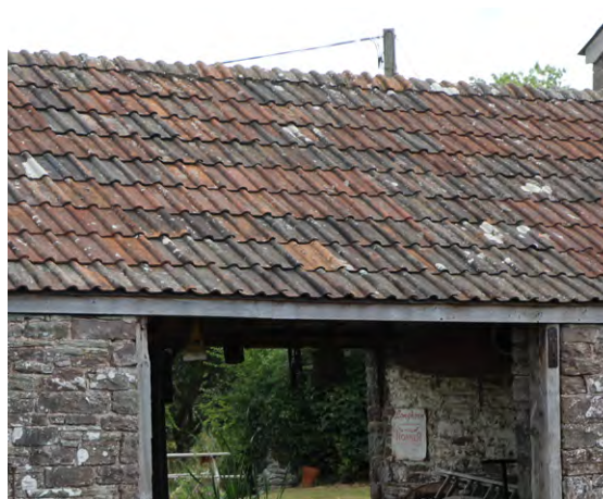
Teils clai dwbl Bridgewater Rhufeinig yng Nghwrt Pencelli – o bosibl wedi codi'r gamlas sy'n rhedeg ochr yn ochr â'r fferm i ail-doi'r ysgubor. Llun © Sam Hale
