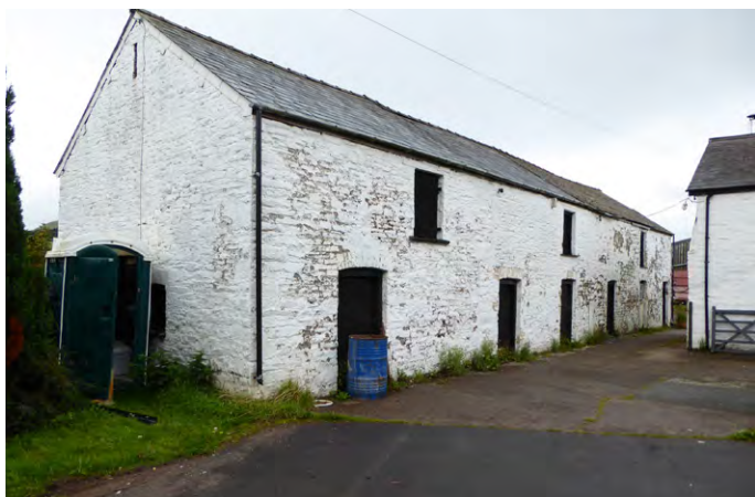
Beudy deulawr gyda'i res o ddrysau i stalau a llofft wair, ger Crai yn Isafonydd Gorllewin Wysg. Ceir enghreifftiau ffrâm bren o'r rhain yn dyddio o ddiwedd yr 16 es ganrif ar hyd Siroedd y Gororau, ond ym Mannau Brycheiniog mae'r strwythurau hyn o gerrig i gyd yn dyddio o'r 19 es ganrif. Nid oes unrhyw enghreifftiau cynharach wedi'u nodi eto. Llun © Jeremy Lake
