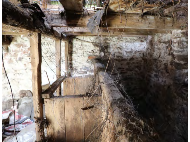
Tu mewn gyda chysylltiadau buchod siamffrog a llwybr porthiant, Llanigon. Lluniau © Sam Hale Clymau buwch sengl syml mewn ysgubor gyfunol, Dyffryn Crawnon – sylwch ar y llofft uchod gyda pholion cyll wedi eu bwndelu. Llun © Sam Hale
