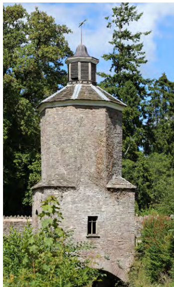
Y colomendai gwych yn Abercamlais a Phen-pont. Yn Abercamlais mae'r colomendy carreg hynod o'r 18 fed ganrif yn eistedd ar bont dros Afon Camlais, gyda sylfaen a arferai fod yn geudy ag elifion a gludwyd gan y nant i mewn i'r Wysg. Ym Mhen-pont mae'r colomendy ffrâm bren o'r 18 fed ganrif wedi'i godi ar bileri cerrig, gyda siambr ar y llawr cyntaf a mynediad colomennod trwy agoriadau bychain yn y cwpolâ gwydrog. Llundun © Sam Hale
